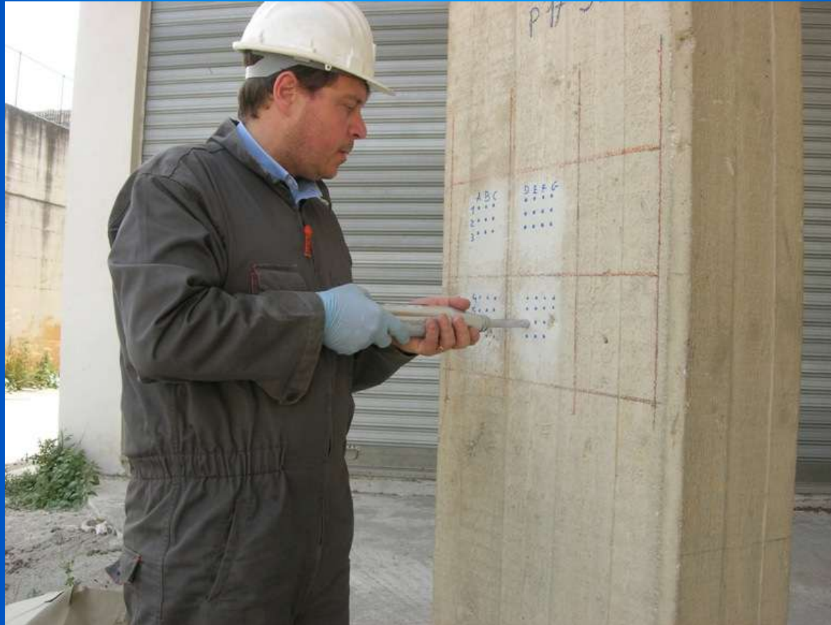
Esecuzione delle battute sclerometriche
