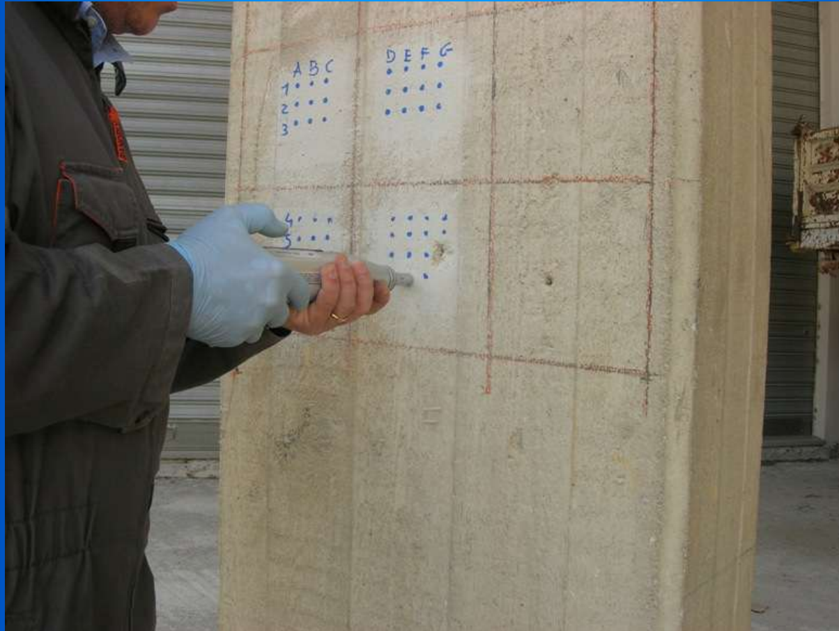
Esecuzione delle battute sclerometriche
