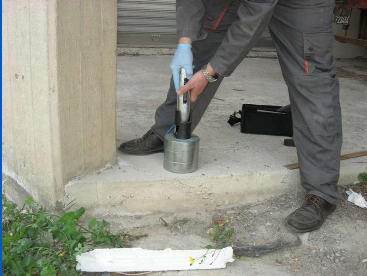
Verifica dello sclerometro all'incudine di taratura
