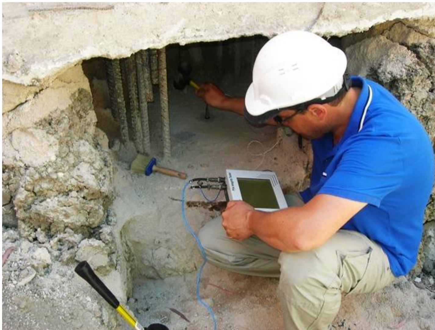
Esecuzione di indagine Pile Integrity Test
