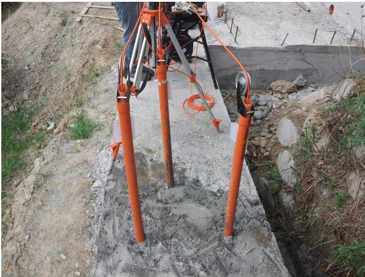
Esecuzione di prova Cross-Hole
