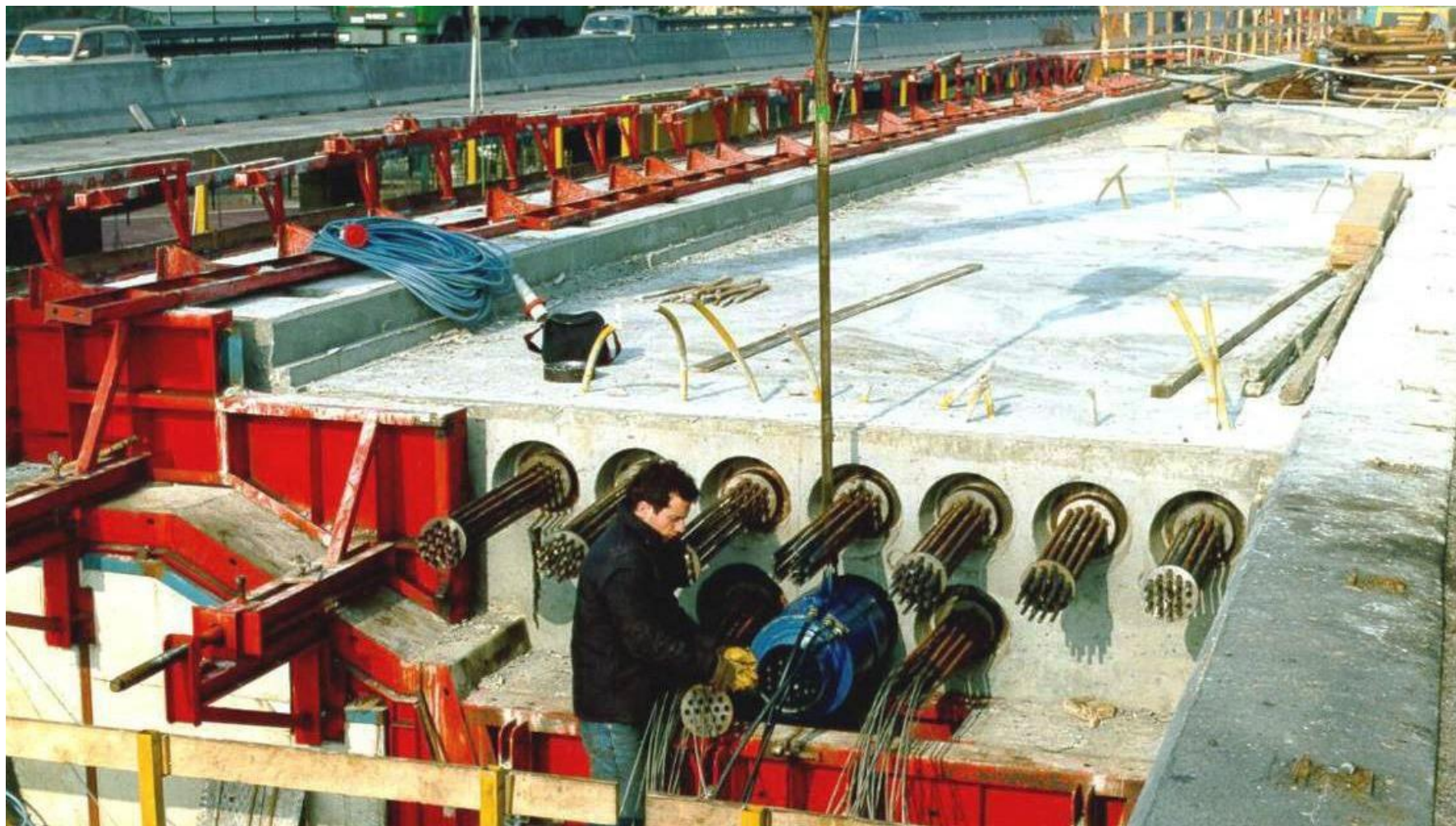
Sistema di precompressione a cavi post tesi
