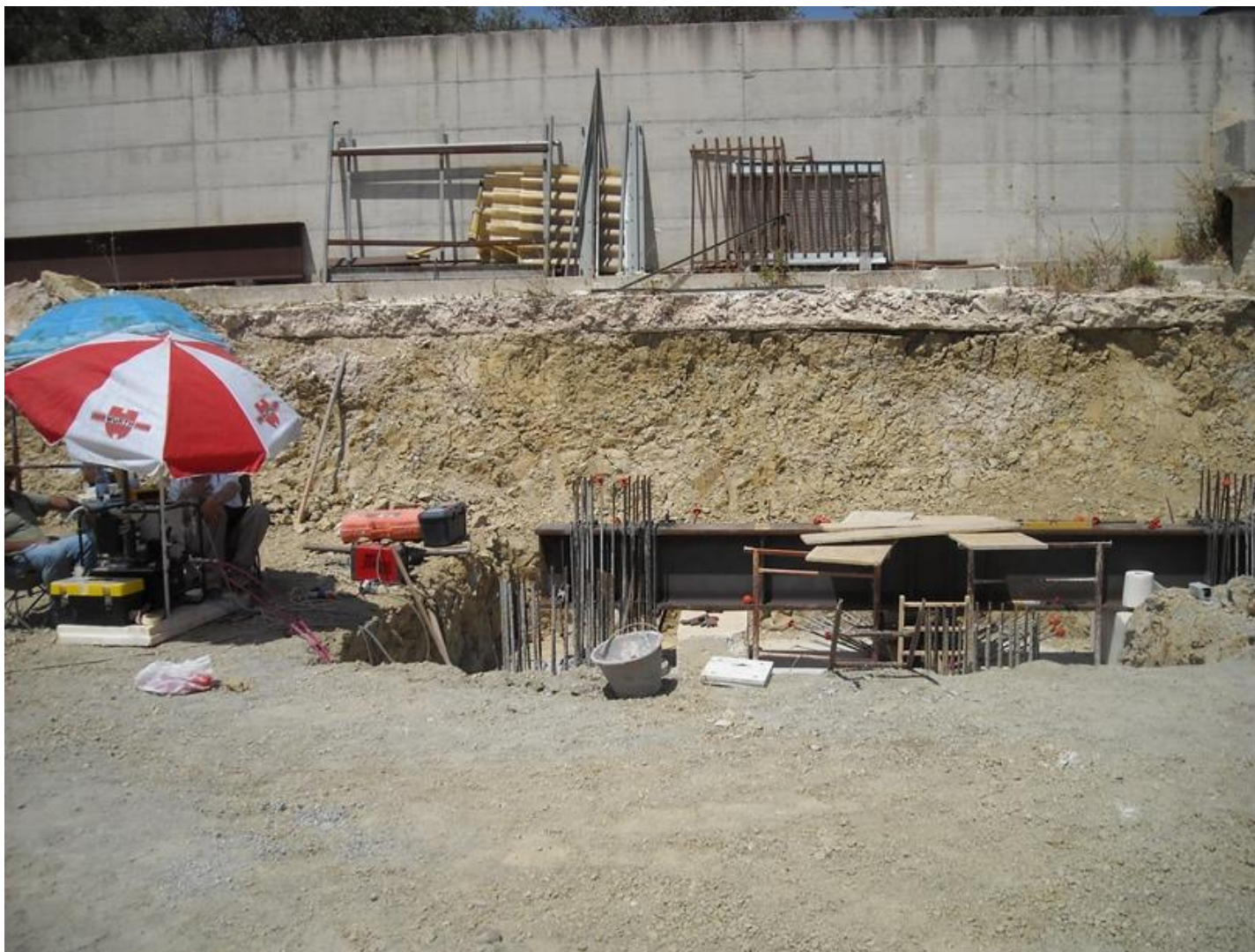
Prova di carico su palo: contrasto costituito da una trave in acciaio rinforzata, ancorata a due pali adiacenti
