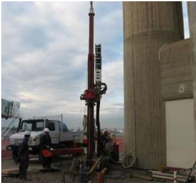
Carotaggio del palo
