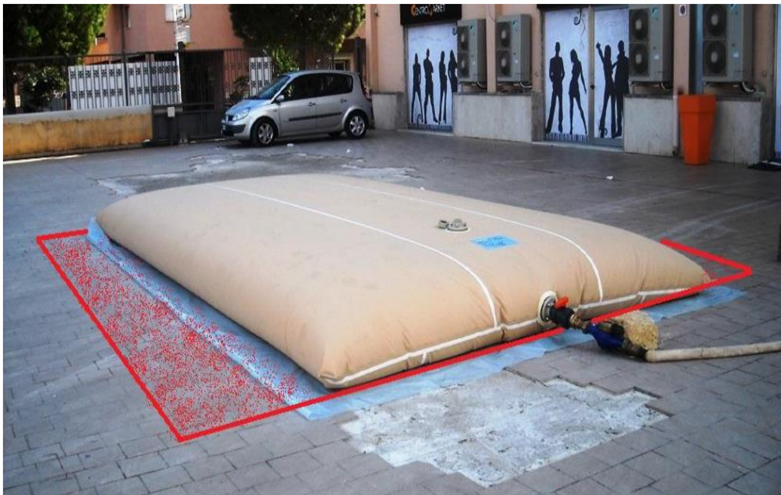
Esempio di prova di carico: serbatoio zavorra
