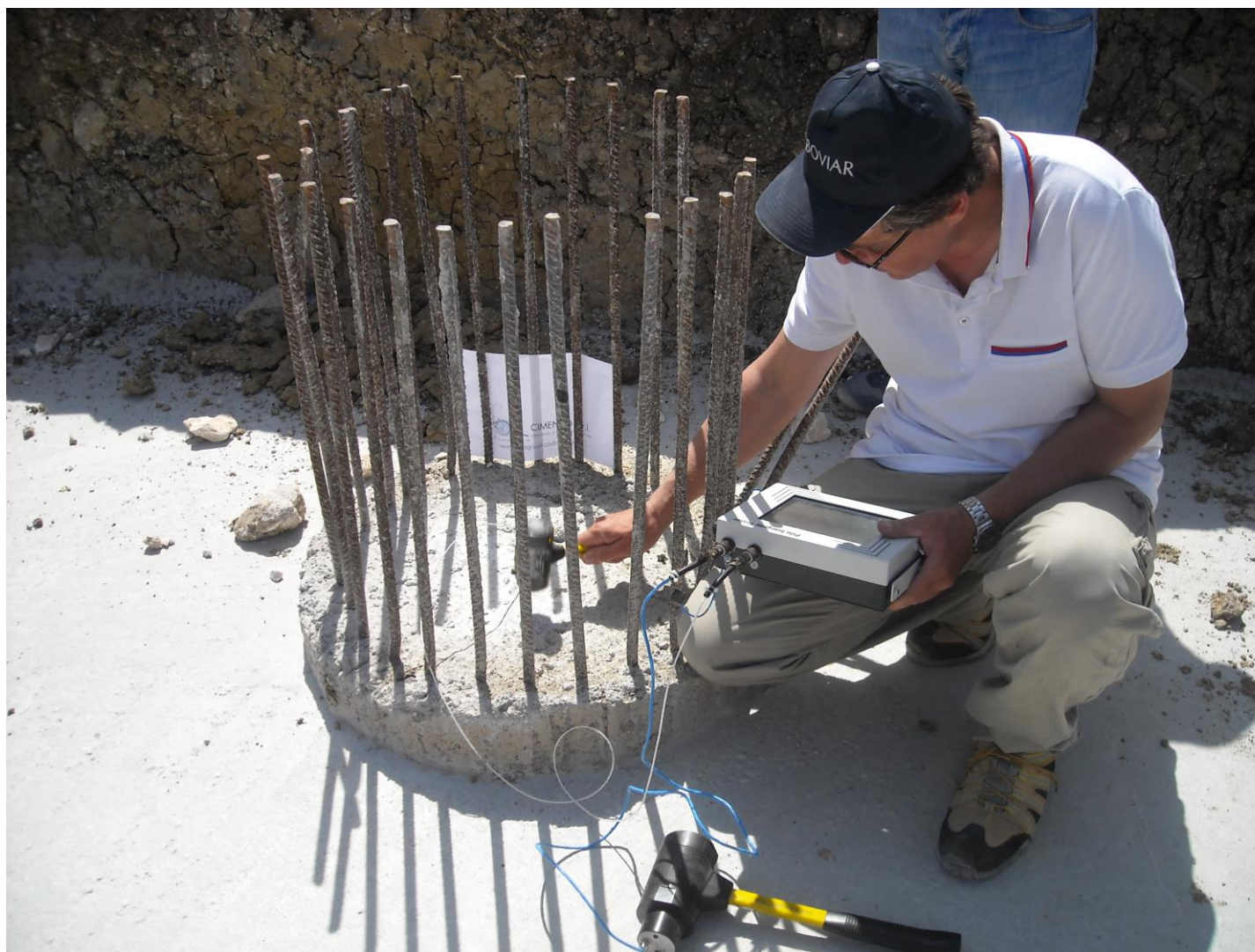
Esecuzione di indagine Pile Integrity Test
