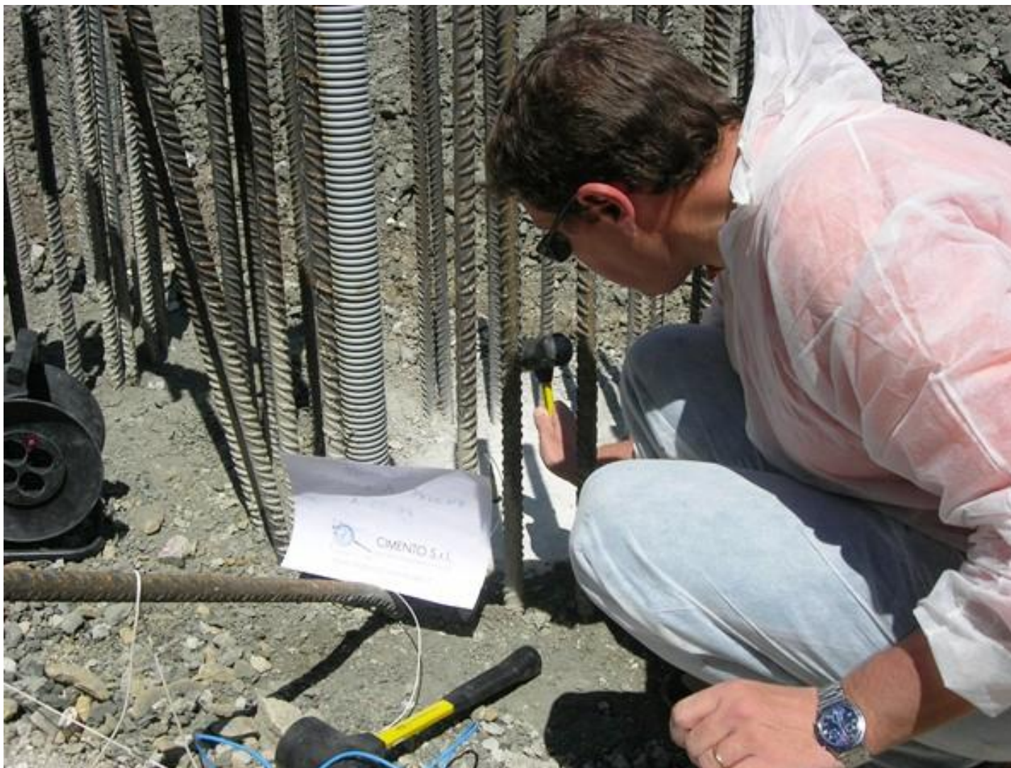
Esecuzione di indagine Pile Integrity Test
