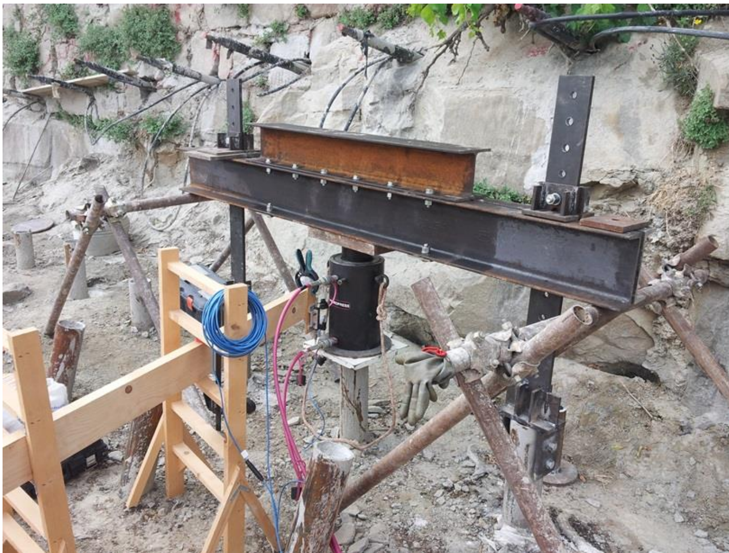
Prova di carico su micropalo: contrasto costituito da una coppia di travi in acciaio ancorata a due micropali adiacenti
