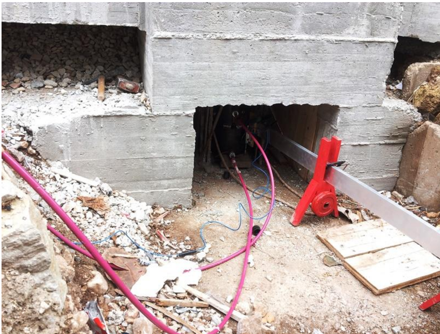
Prova di carico su palo: contrasto costituito dalla platea di fondazione
