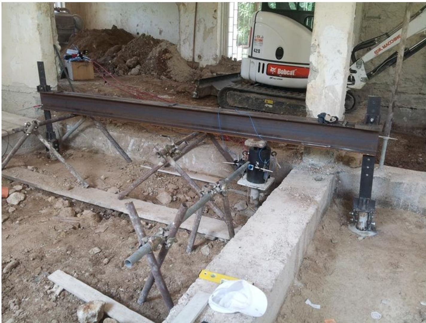
Prova di carico su micropalo: contrasto costituito da una coppia di travi in acciaio ancorata a due micropali adiacenti
