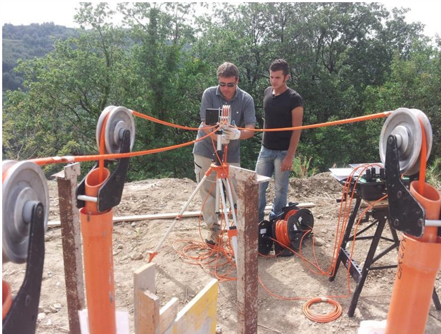
Esecuzione di prova Cross-Hole
