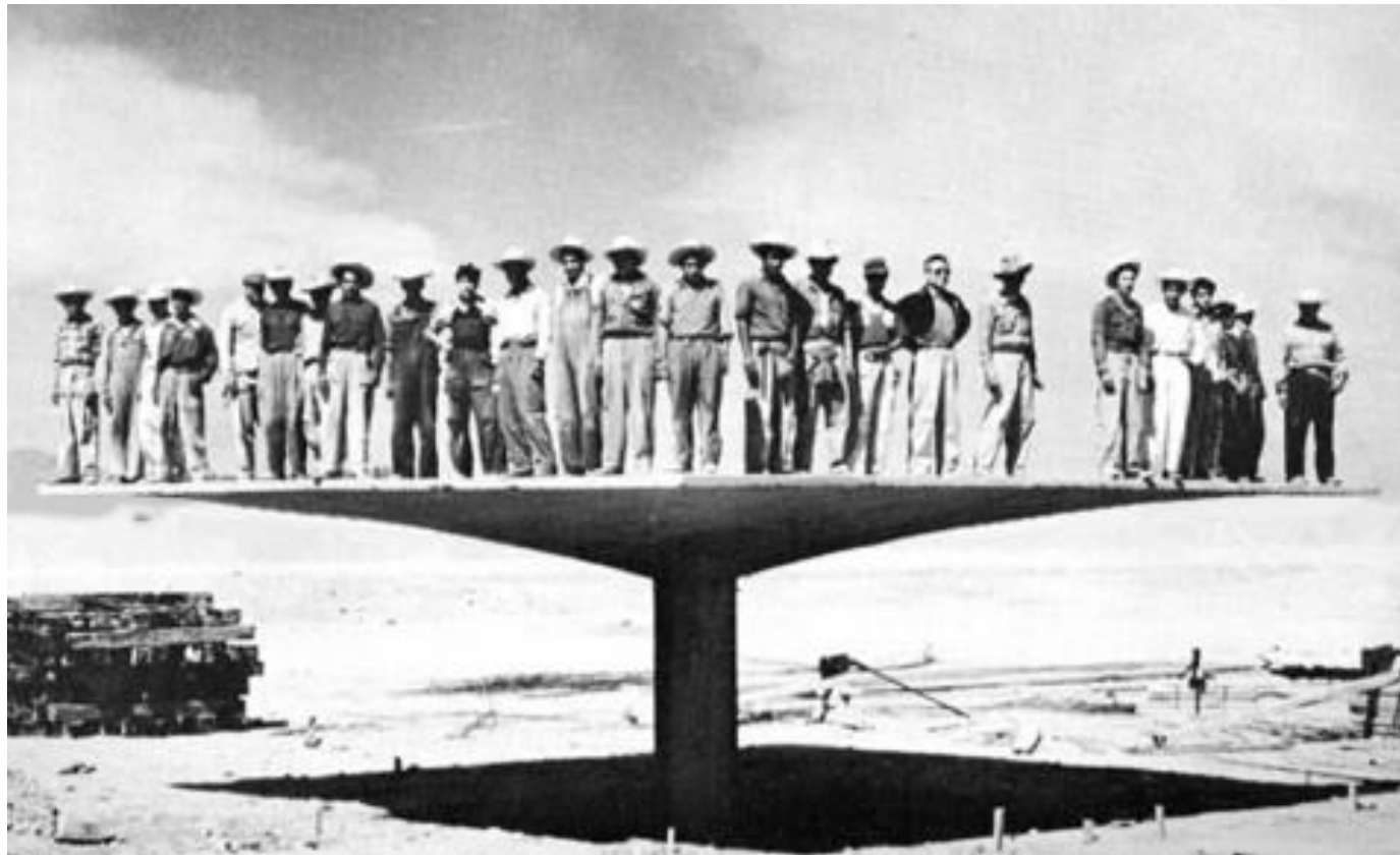
L'architetto Felix Candela esegue una prova di carico su un pilastro ad ombrello (anni '50)
