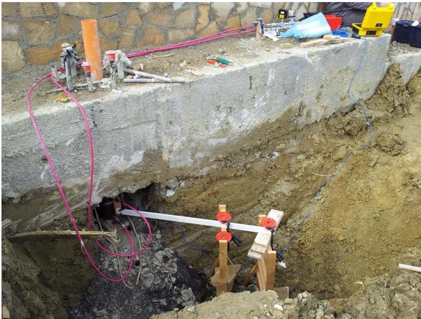
Prova di carico su palo: contrasto costituito dalla base del muro di sostegno
