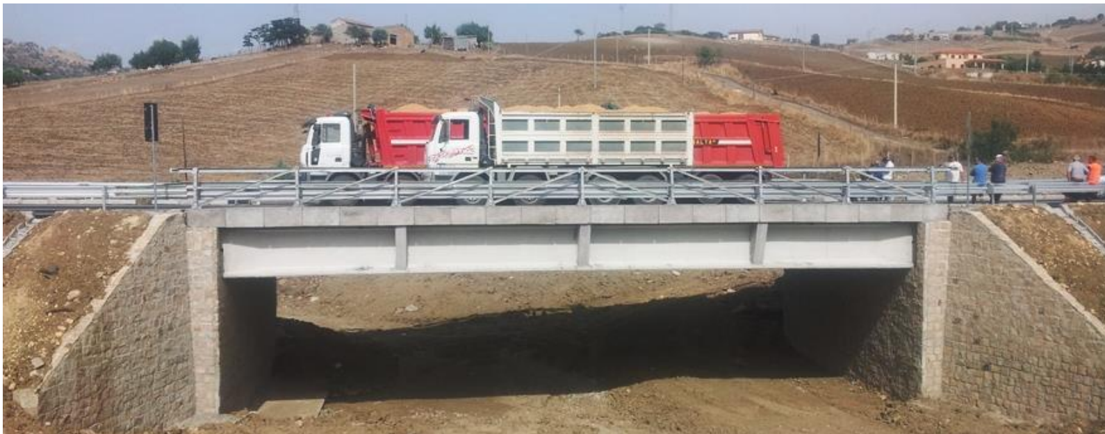
Prova di carico su ponte stradale a campata unica in c.a.p. – Fonte CIMENTO S.r.l.
