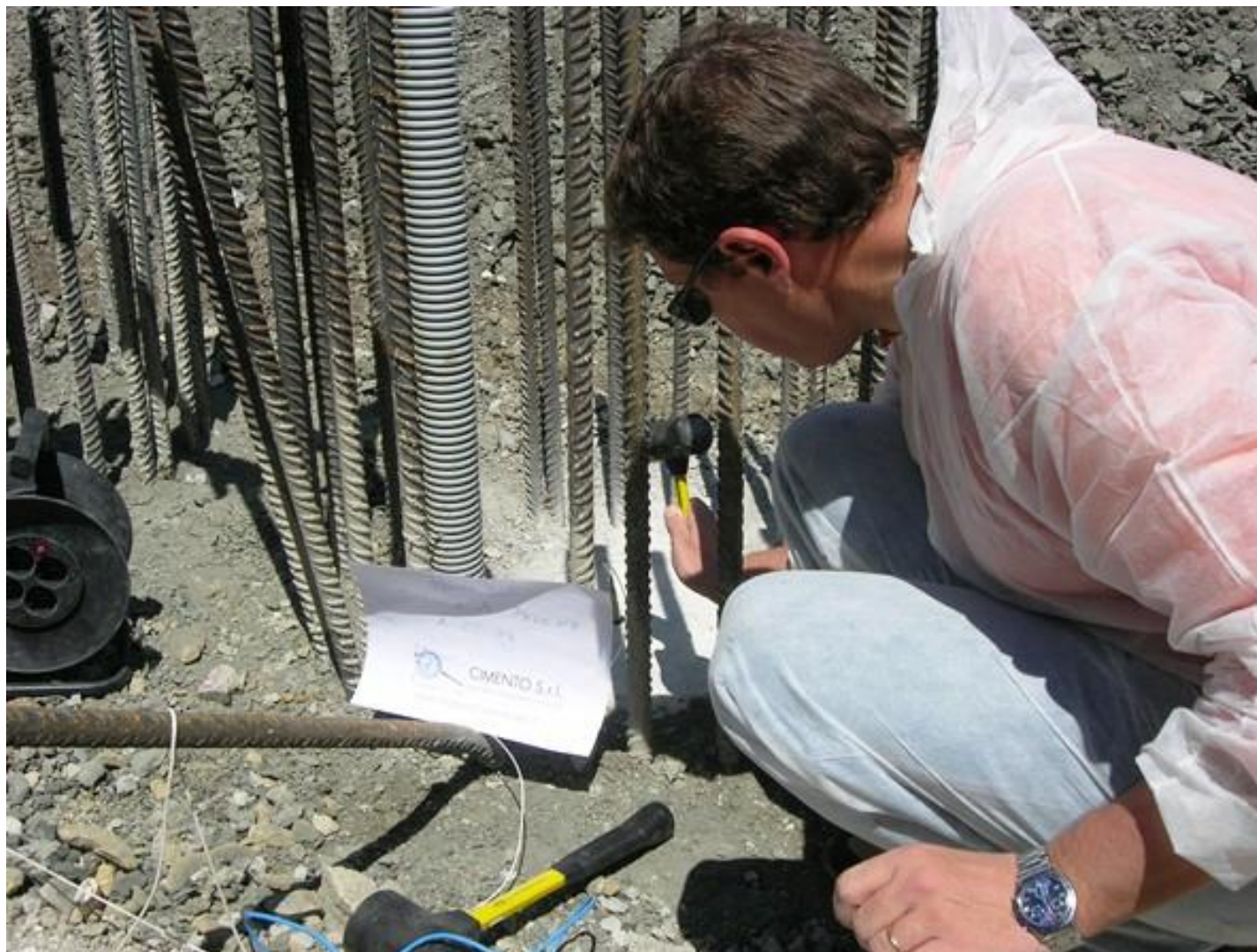
Esecuzione di indagine Pile Integrity Test
