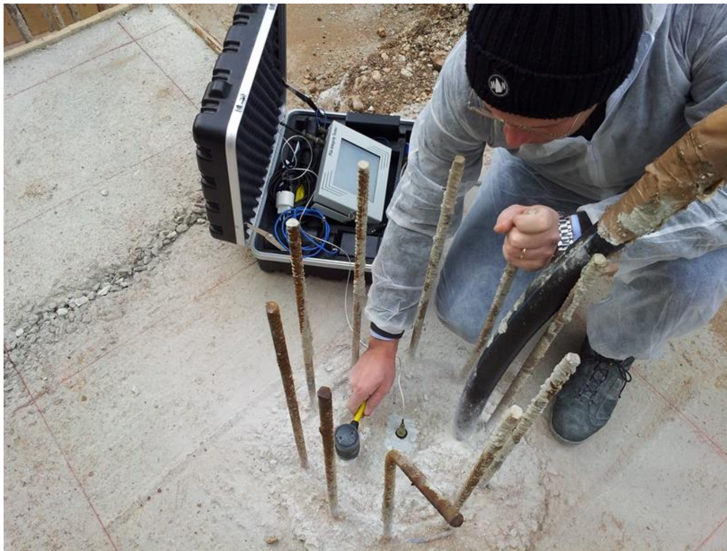
Esecuzione di indagine Pile Integrity Test
