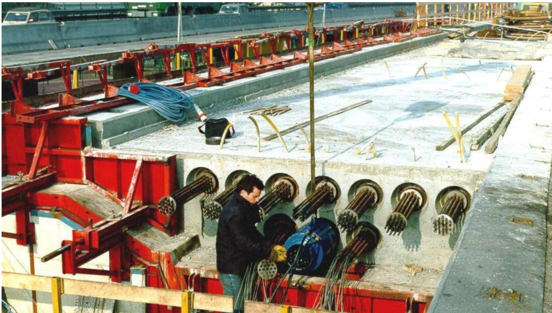
Sistema di precompressione a cavi post tesi
