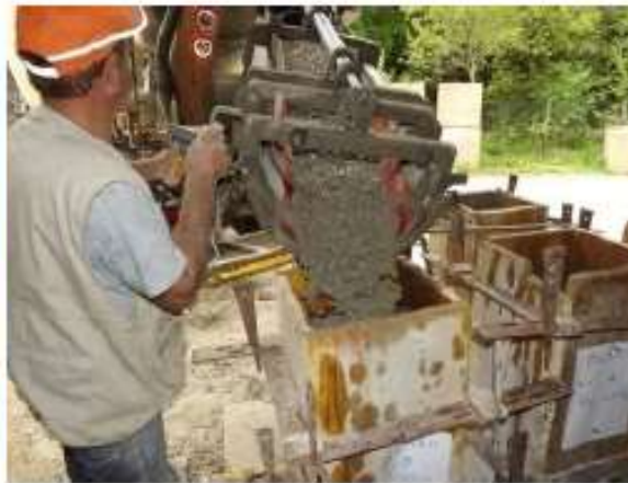
Fasi di getto dei pilastrini
