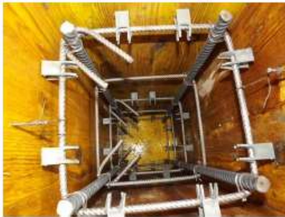
Armature metalliche dei pilastrini
